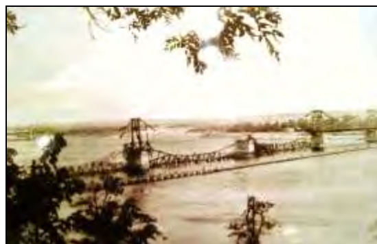
Підірваний київський міст через Дніпро
