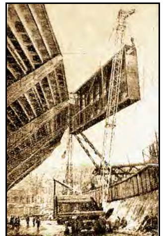
Монтаж електронного табло 8 квітня 1969 р.
