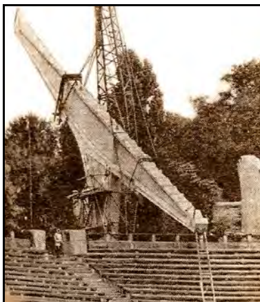
Встановлення консолі другого ярусу
