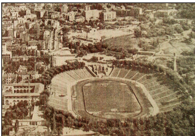
Республиканский стадион им. Хрущева (вид с верху) - идет застройка прохода за "бессарабскими" воротами и строительство Дворца спорта.
