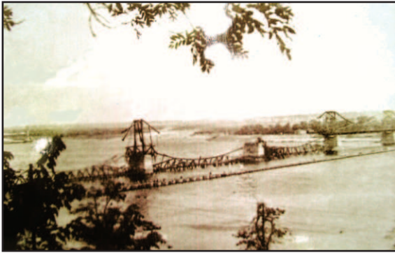
Разрушенный киевский мост через Днепр
