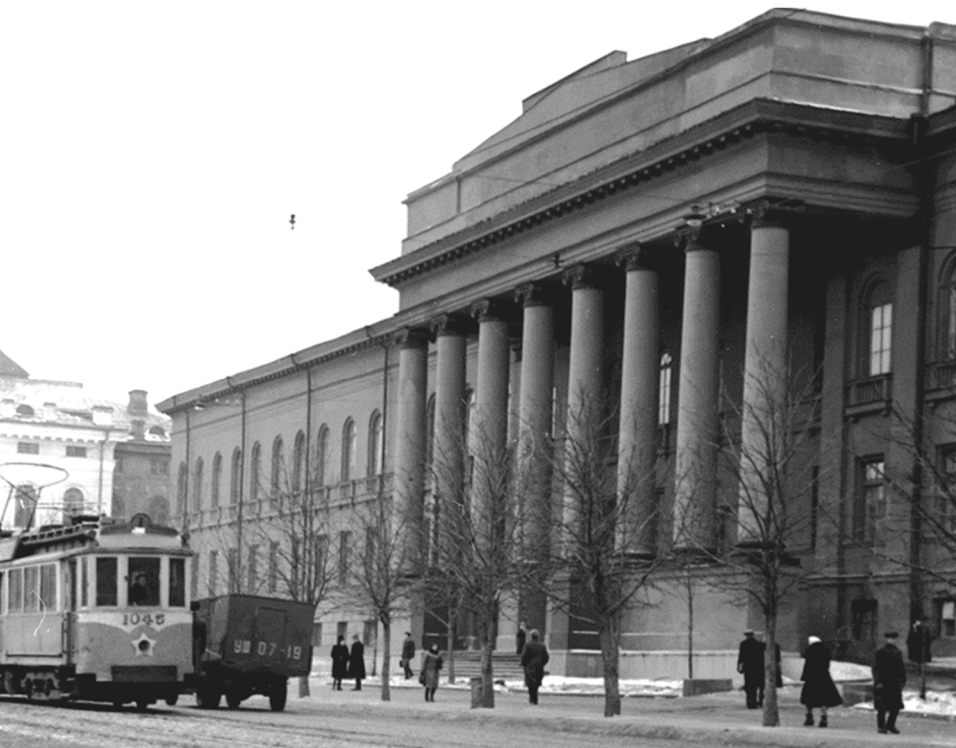
Фасад відновленого головного корпусу Київського університету (1949)
