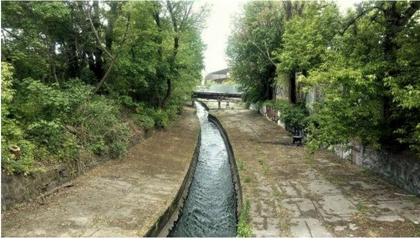
Рис. 1.18. Відкрите бетонне русло міської річки Либідь, м. Київ, 2021 р.
