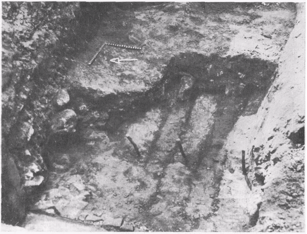
Рис. 3. Металлические колья и следы деревянных субструкций в фундаментах Федоровского монастыря
