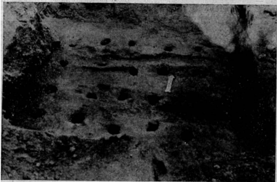
Рис. 2. Система кілків під фундаментами південної стіни.
