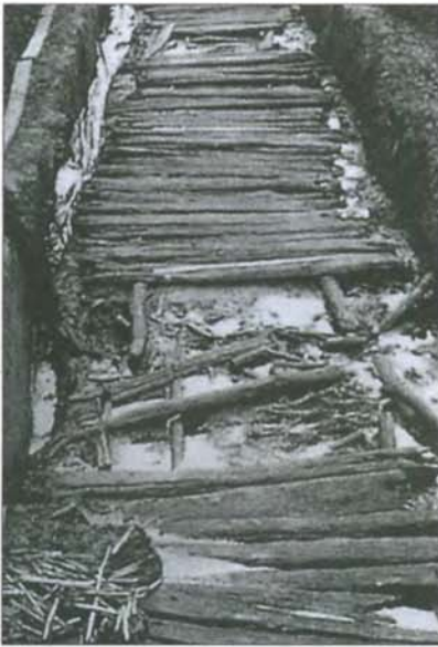
Фрагмент дерев'яної вимостки дороги
