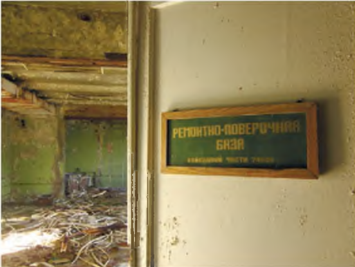
Ремонтно-поверхнова база. Приміщення обчислювального центру. Містечко Чорнобиль-2
