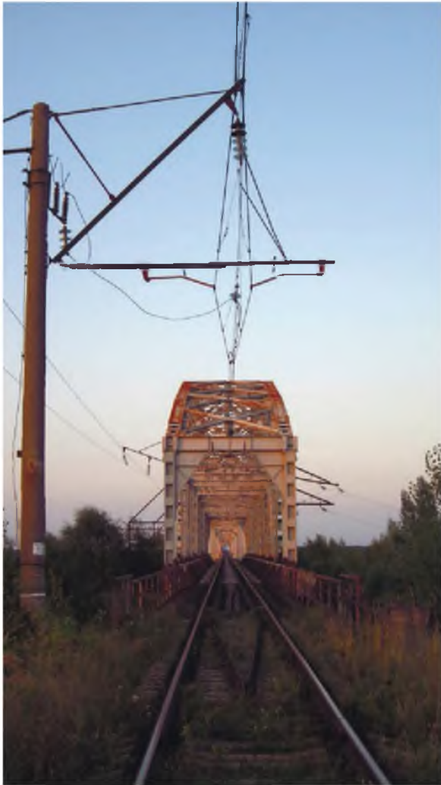
Залізничний міст через ріку Прип'ять. Ділянка залізниці Славутич-ЧАЕС. Один з найжолоритніших маршрутів нелегальних туристів до «Мехки» - хинутої церкви у селі Красно
