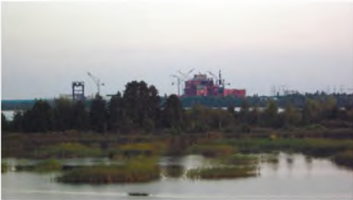
Недобудований 5-й енергоблок ЧАЕС
