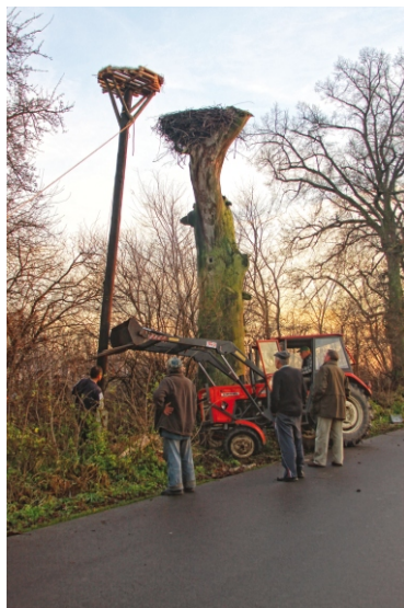
Встановлення окремої опори з гніздом (фот. А.Василюк)
