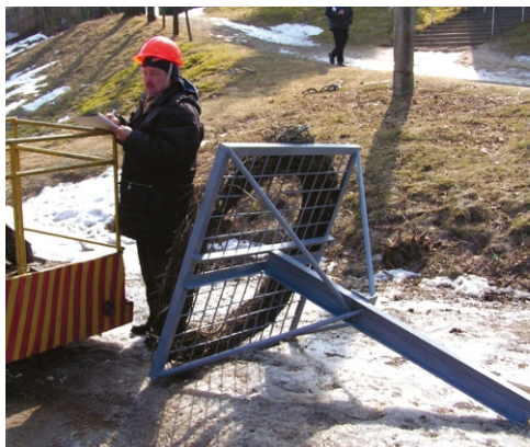
Українські енергетики готуються до монтажу платформи на електричний стовп (фот. Н.Дзюбенко)
