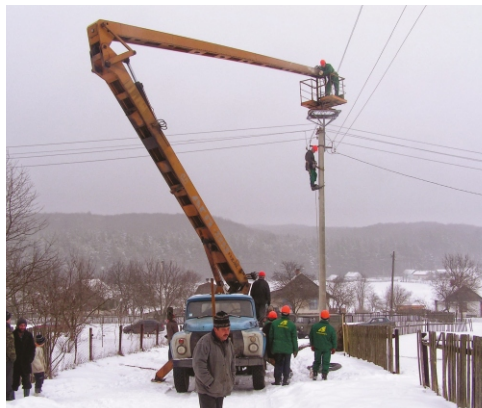
Монтаж платформи на електричній опорі (фот. А.Бокотея)
