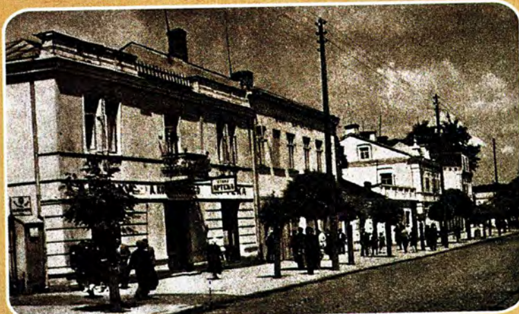
м. Володимир, вул. Маршалка Пілсудського (20–30-ті роки XX ст.) ВКМ, інв. № ОМ-1528
