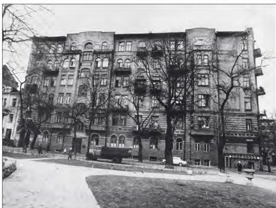
Рисунок 10. Фасад з боку вул.О.Гончара. Фото 1999 р.
