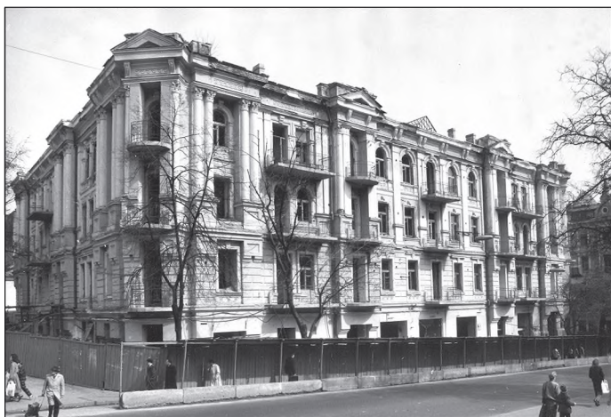
Рисунок 5. Відселений перед капітальним ремонтом будинок. Фото 1990 р.
