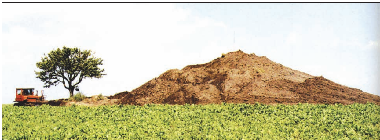
Рис. 94. Конечный этап восстановления насыпи БРК
