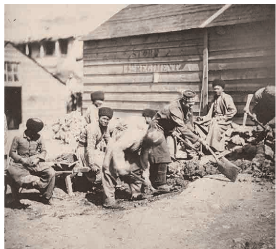
На роботах з ремонту проїжджої частини у Балаклаві. Фото 1855 р.
