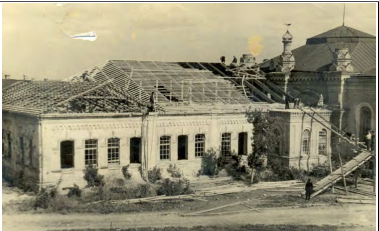
Післявоєнне фото колишнього Будинку намісника під час ремонту даху. Праворуч – будівля Покровської церкви
