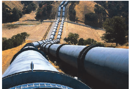
Одна з ділянок газопроводу Дашава – Київ
