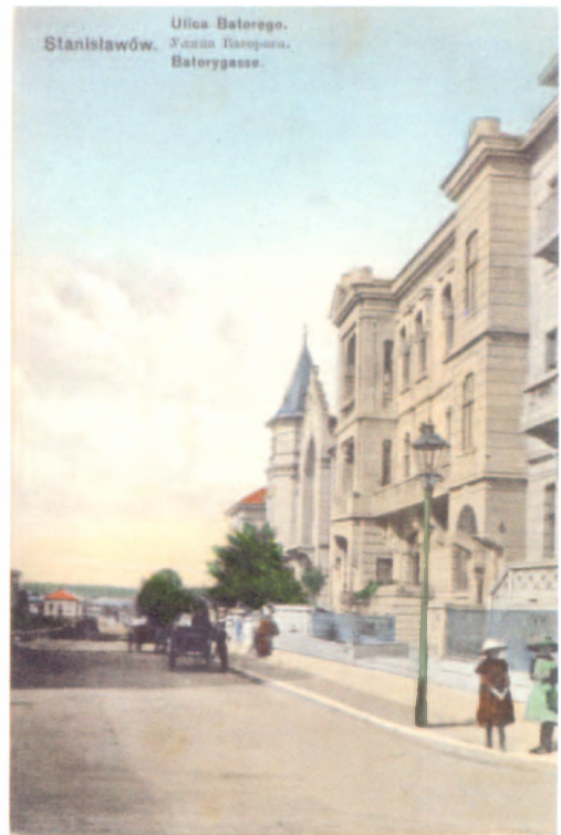
Вулиця Баторего (тепер – вул. Короля Данила)
