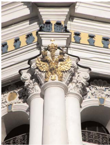
489.1.2. Фрагмент фасаду четвертого ярусу.
