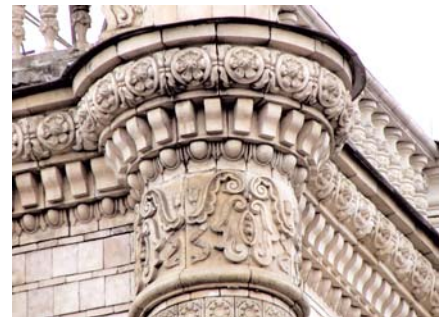
544.6. Фрагменти оздоблення фасаду.
