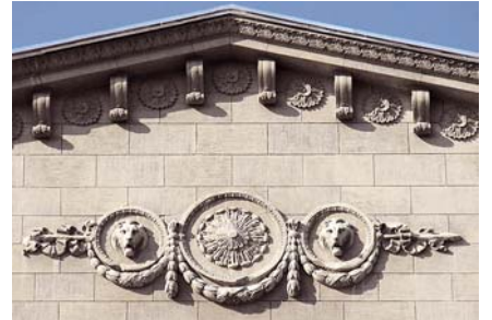
544.18. Фрагменти оздоблення фасаду.
