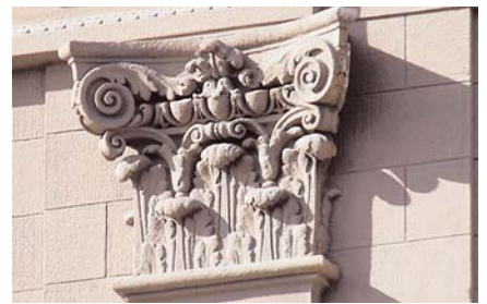
544.19. Фрагменти оздоблення фасаду.
