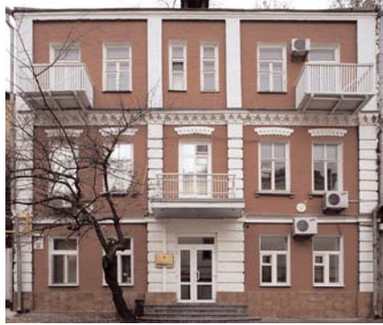
544.25. Вул. Хрещатик, 50-в.
