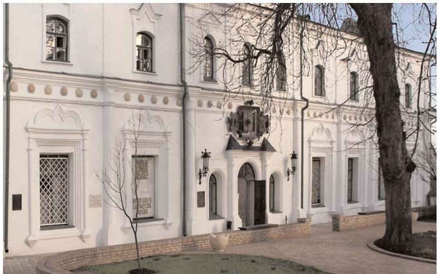
489.1.14. Фрагмент західного фасаду.
