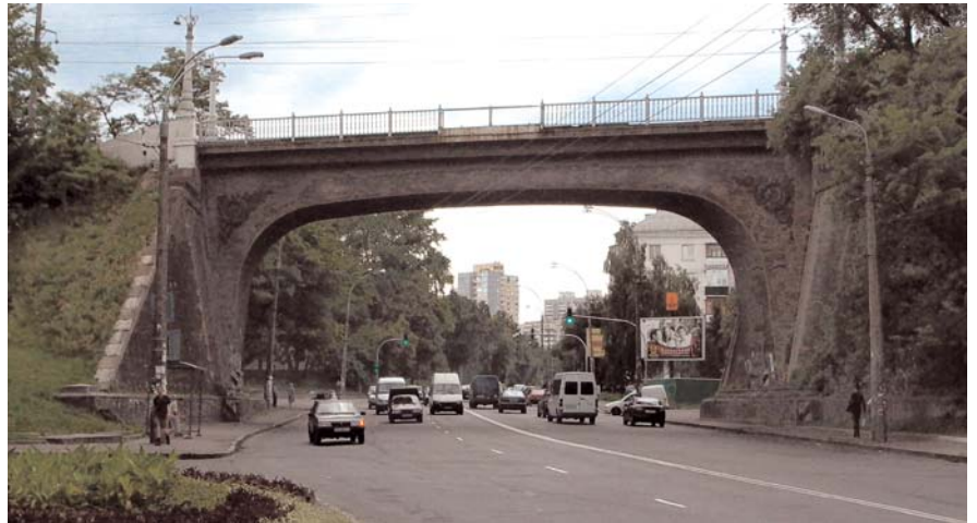
567. Шляхопровід Куренівський залізничний (вул. Фрунзе — вул. Вишгородська).
