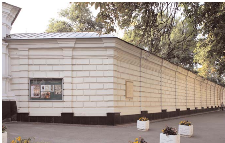
503.11. Фасад пристінного корпусу.
