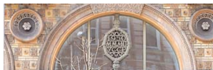
561.12. Фрагменти оздоблення фасаду.
