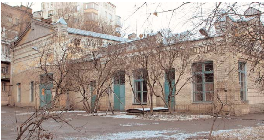
510. Станція водогінна насосна.
