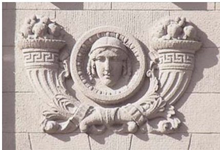
544.18. Фрагменти оздоблення фасаду.
