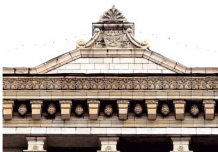
544.16. Фрагменти оздоблення фасаду.
