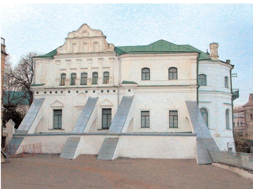
489.1.14. Південний (бічний) фасад.
