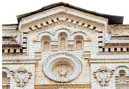
576.22. Фрагменти оздоблення фасаду.
