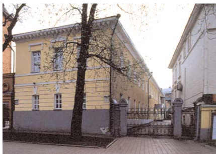
496.12. Вул. Січневого повстання, 6-б.
