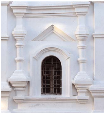
489.1.53. Оздоблення вікна південного фасаду.
