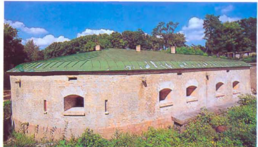
207.3.2.3. Капонір другого полігона. Вул. Госпітальна, 24-а.
