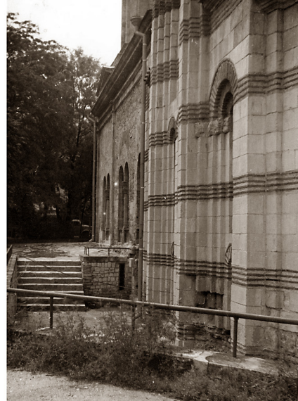
Фото 46. Прямок до первісної відмітки землі. Після реставрації. 1982 р. Фото Є. Лопушинської
