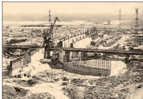
Будівництво Каховської ГЕС. 1953 р.
