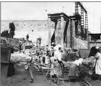
Жінки на відбудові Дніпрогесу. Запоріжжя. 1947 р.
