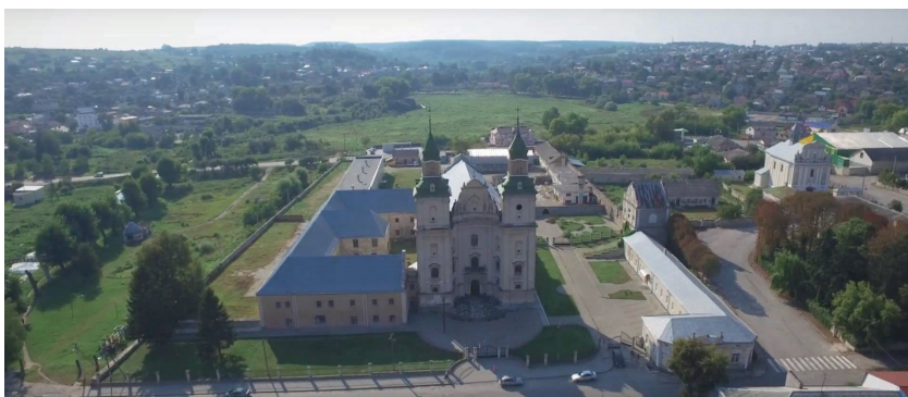
Рис. 8. Вигляд монастирського комплексу зверху.
