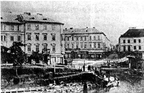
Роботи по перекриттю Полтви 1887 р.
