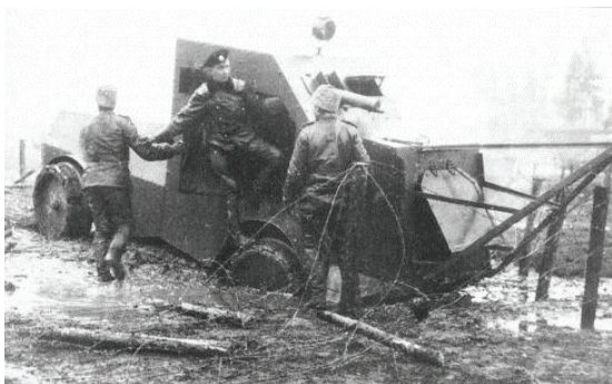
Віктор Поплавко на підніжжі випробувального екземпляру кулеметного бронемобіля «Чародій», який він спроектував і створив на базі повноприводної вантажівки «Jeffery Quad 4017» виробництва американської фірми «Thomas V. Jeffery Company» (1916 р.).
