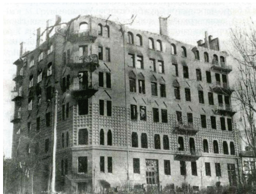
Будинок Грушевських у Києві після більшовицького артобстрілу. 1918 р., світлина Ф. Ернста (17 червня 1921 р. будинок М. Грушевського було остаточно зруйновано)
