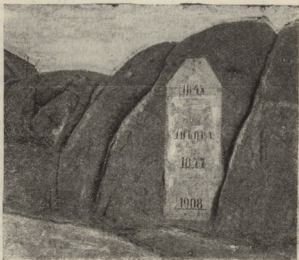
Водомірна рейка на головній вул. Кичкасу. Висічено на скелі
