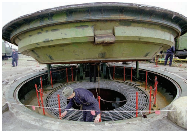
Захисний пристрій шахтно-пускової установки ракети РС-22.
