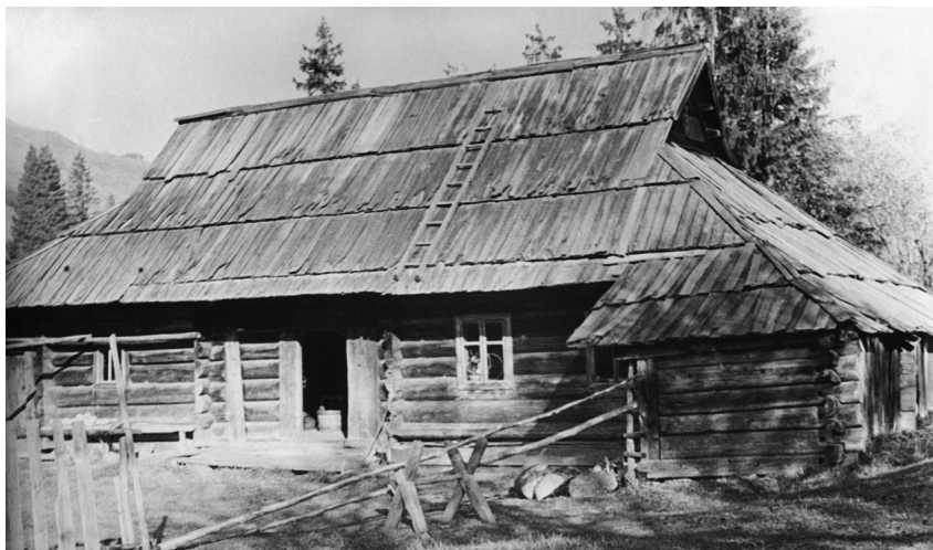
Соотношение высоты стен и крыши. Дом в Бережнице
