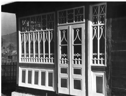
Галерея теперь застеклена. Дом в Верховине
