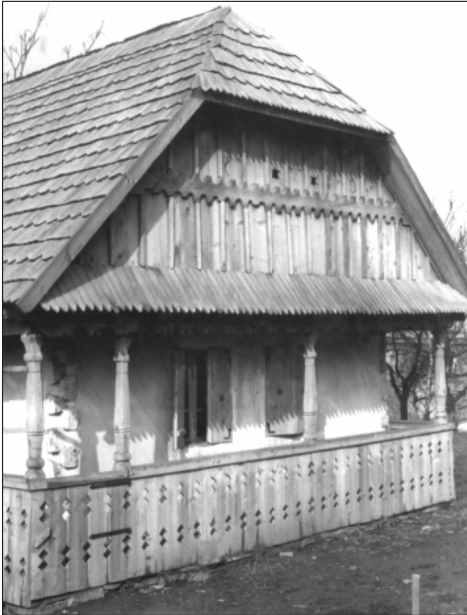
Хата з села Ракошино Мукачівського району 1868 р. з побіленим зрубом і дахом з усіченими зверху фронтонами, вкрита гонтом ("шинглями"). Знаходиться в експозиції Музею народної архітектури і побуту в Ужгороді
