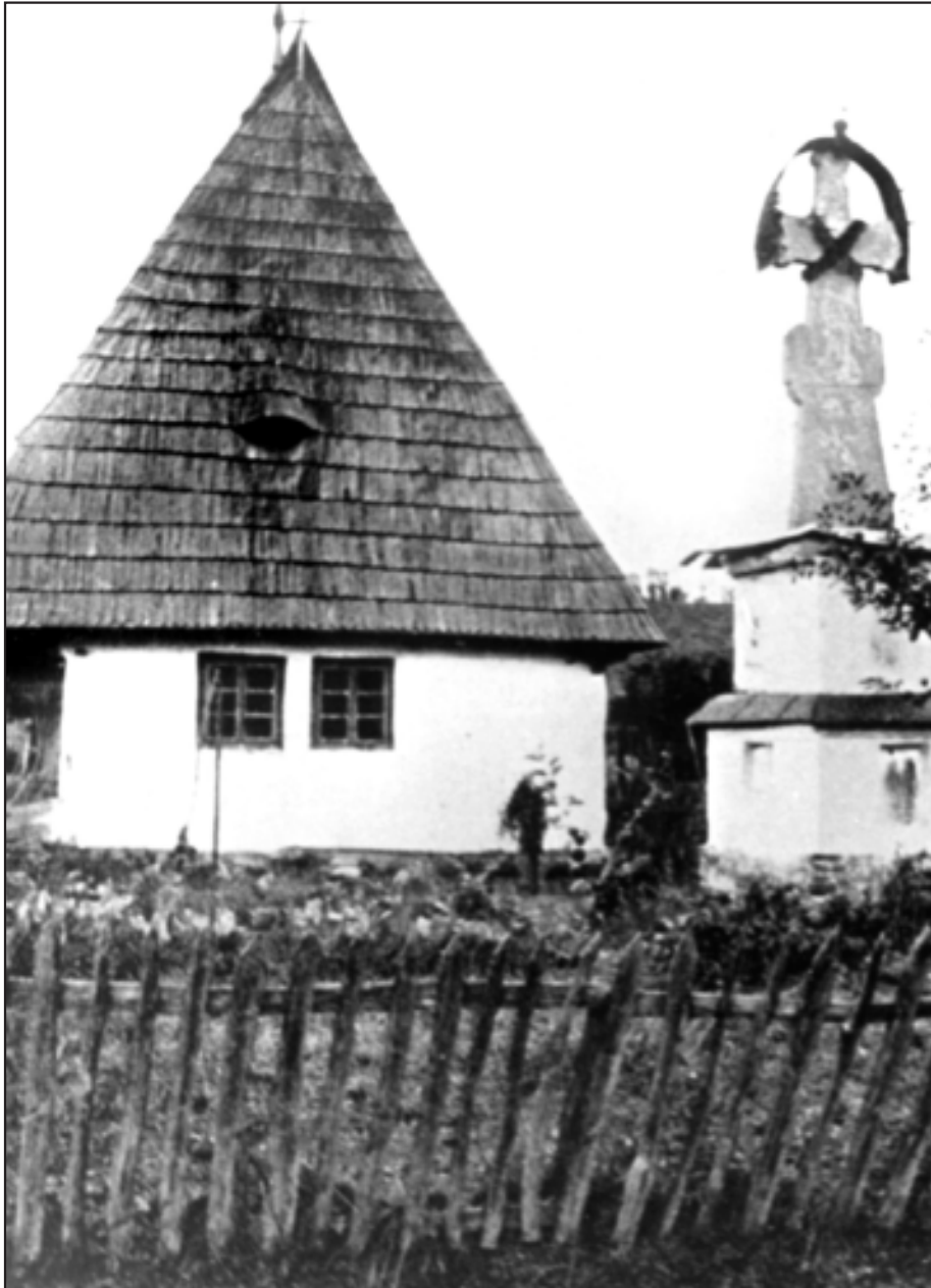
Хата з побіленим зрубом, чотирисхилим високим, покритим гонтом, дахом та шестишибковими вікнами у селі Золотарево Хустського району. Фото 20-х років XX ст.
