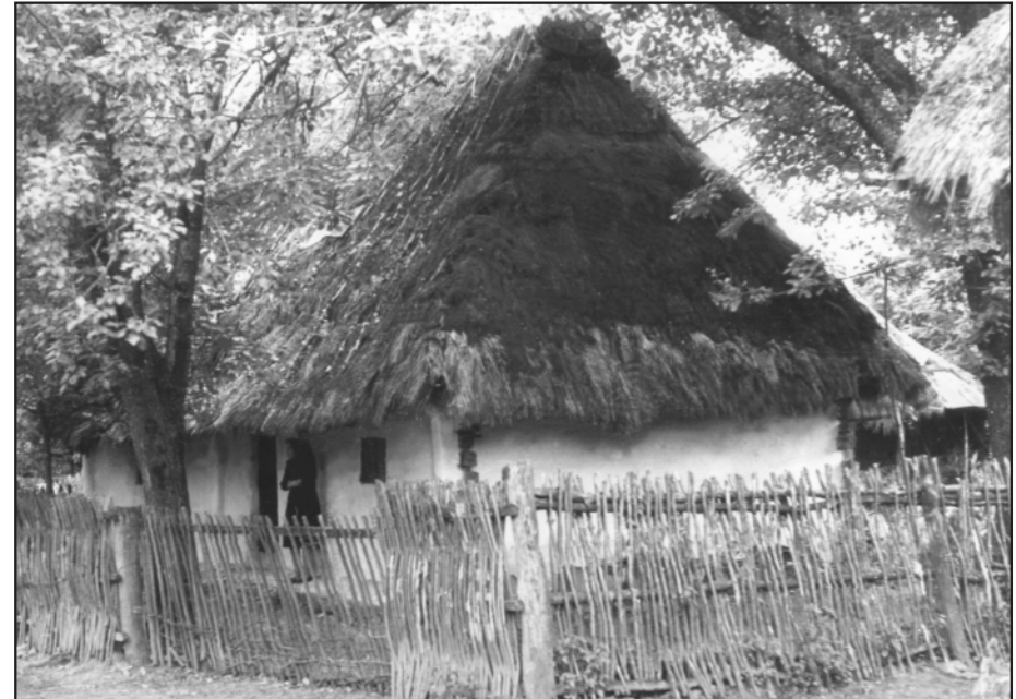
Хата 1870 року з обмазаним і побіленим зрубом та чотирихилим, вкритим соломом, дахом у селі Гайдош Ужгородського району. Фото автора
