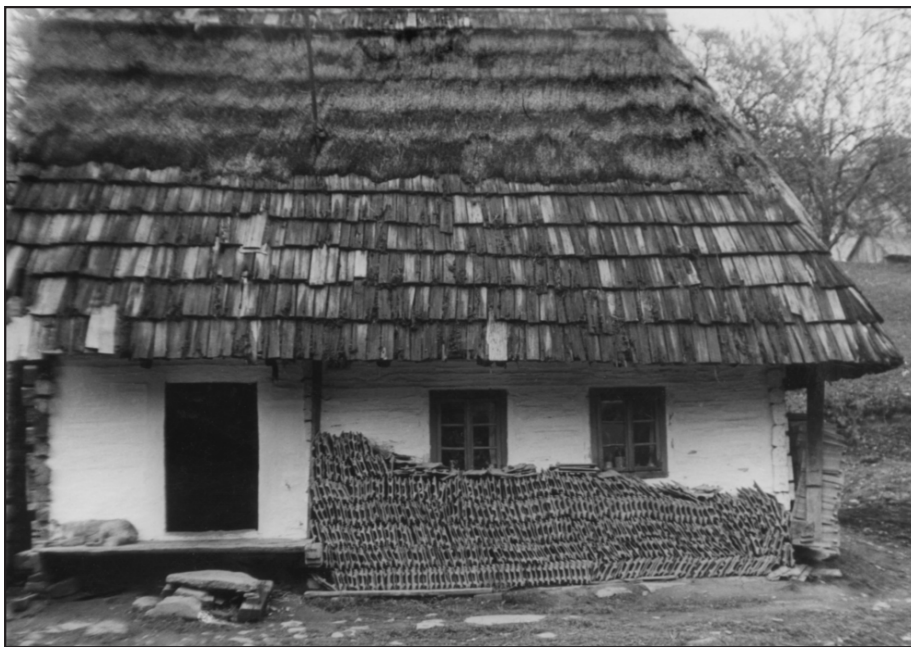
Хата початку ХХ ст. з побіленим зрубом і комбінованою солом'яно-драничною покрівлею у селі Вишка Великоберезнянського району. Фото автора
