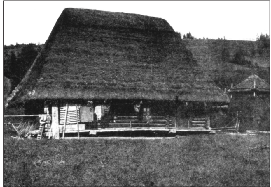
Бойківська хата з відкритим зрубом і високим гостросхилим, вкритим солом'яними сніпками, дахом у селі Подобовець Міжгірського району. Фото початку 20-х років ХХ ст.
