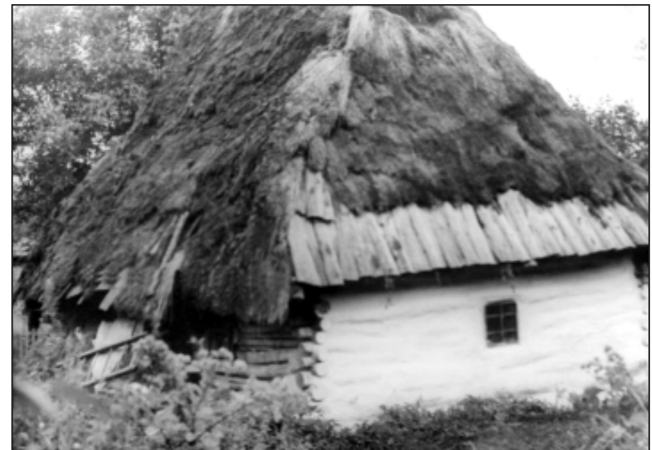
Хата кінця XIX ст. у селі Турички Перечинського району. Зруб складено з кругляків, дах чотирихилий, покритий соломною і дранкою. Фото автора
