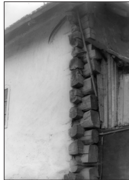
Зв'язування протесів зрубу в хаті початку XX ст. у селі Тур'ї Ремети Перечинського району. Фото автора
