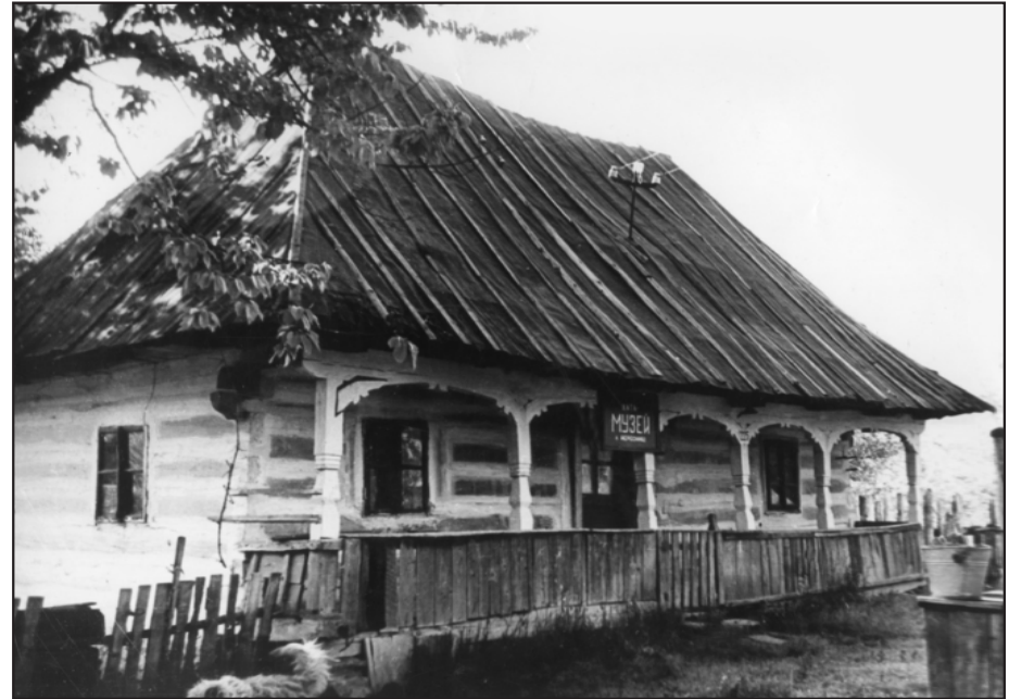
Напіввідкрита галерея з різьбленими опорними стовпцями в хаті кінця XIX ст. у селі Нересниця Тячівського району. Фото автора
