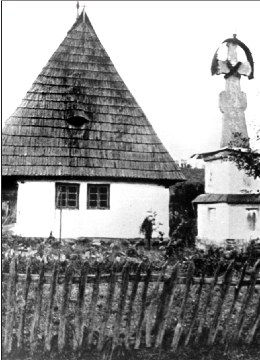
Хата з побіленим зрубом, чотирисхилим високим, покритим гонтом, дахом та шестишибковими вікнами у селі Золотарево Хустського району. Фото 20-х років XX ст.
