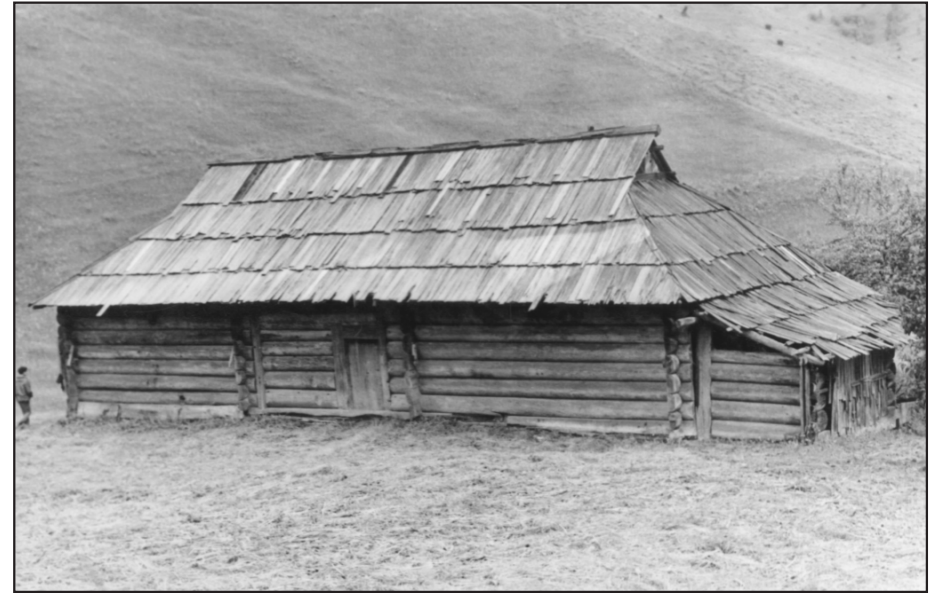
Тильний бік гуцульської Хати кінця XIX ст. у селі Кваси Рахівського району з характерним відкритим зрубом і чотирисхилим, з невеличкими фронтончиками у верхній частині її фронтальних боків, вкритим дранкою дахом. Фото автора
