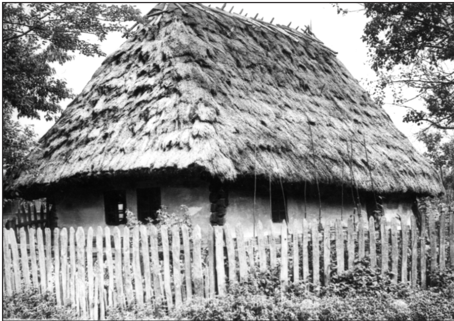
Хата середини XIX ст. з обмазаним і побілим зрубом, чотирихилим дахом під соломою у селі Ворочево Перечинського району. Фото автора
