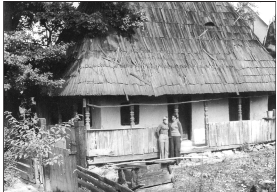
Двокамерне житло (хата+комора-кліть; з окремим входом у комору з галереї) Кінця XIX ст. У селі Стеблівка Хустського району. Фото автора
