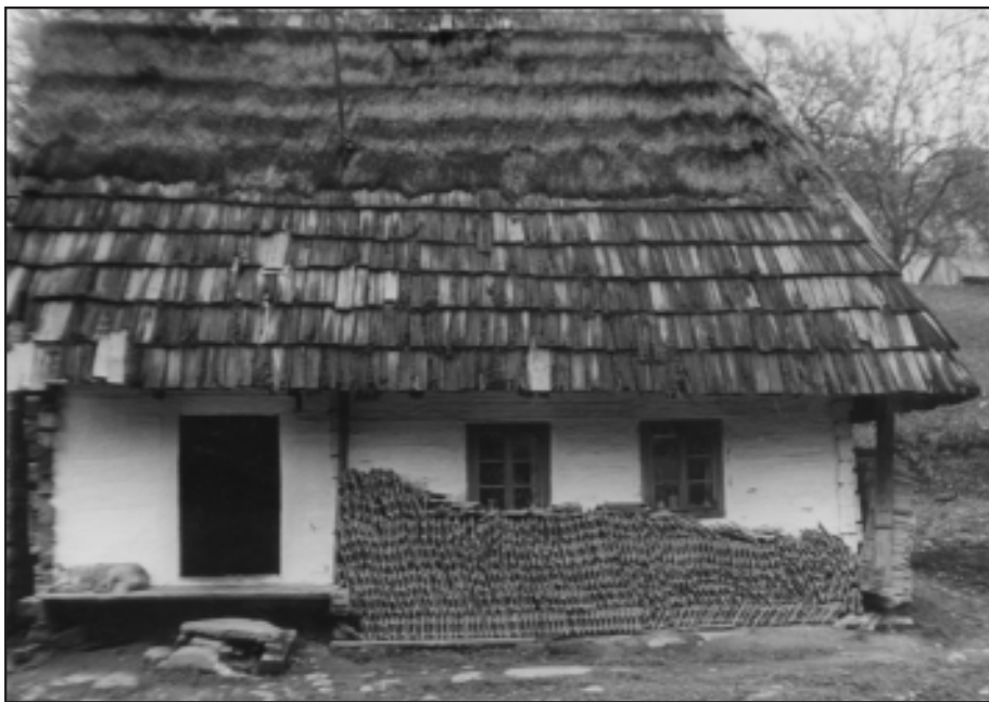
Хата початку XX ст. з побіленим зрубом і комбінованою солом'яно-драничною покрівлею у селі Вишка Великоберезнянського району. Фото автора
