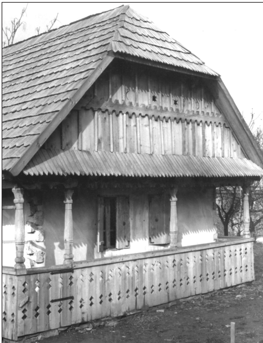
Хата з села Ракошино Мукачівського району 1868 р. з побіленим зрубом і дахом з усеченими зверху фронтонами, вкрита гонтом ("шинглями"). Знаходиться в експозиції Музею народної архітектури і побуту в Ужгороді
