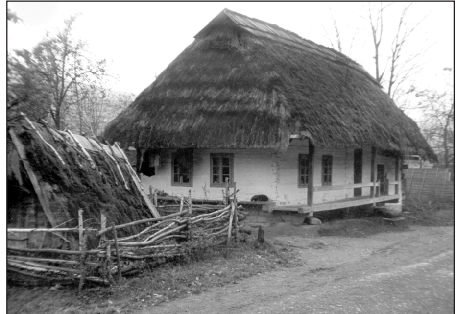
Хата початку ХХ ст. з побіленим зрубом та чотирисхилим солом'яним дахом і характерним дранковим його завершенням у селі Вишка Великоберезнянського району. Фото автора
