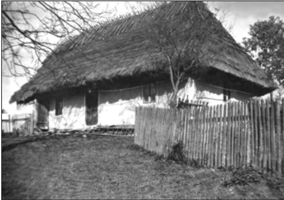
Хата кінця XIX ст. з побіленим зрубом і характерною солом'яною сходоподібною покрівлею ("на ґарадичі") у селі Зарічево Перечинського району. Фото автора
