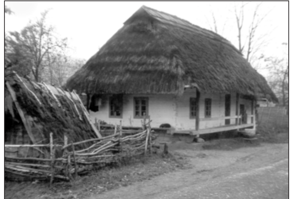
Хата початку XX ст. з побіленим зрубом та чотирисхилим солом'яним дахом і характерним дранковим його завершенням у селі Вишка Великоберезнянського району. Фото автора
