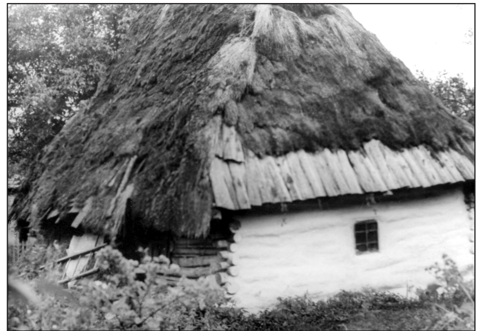
Хата кінця ХІХ ст. у селі Турички Перечинського району. Зруб складено з кругляків, дах чотирихилий, покритий соломом і дранкою. Фото автора
