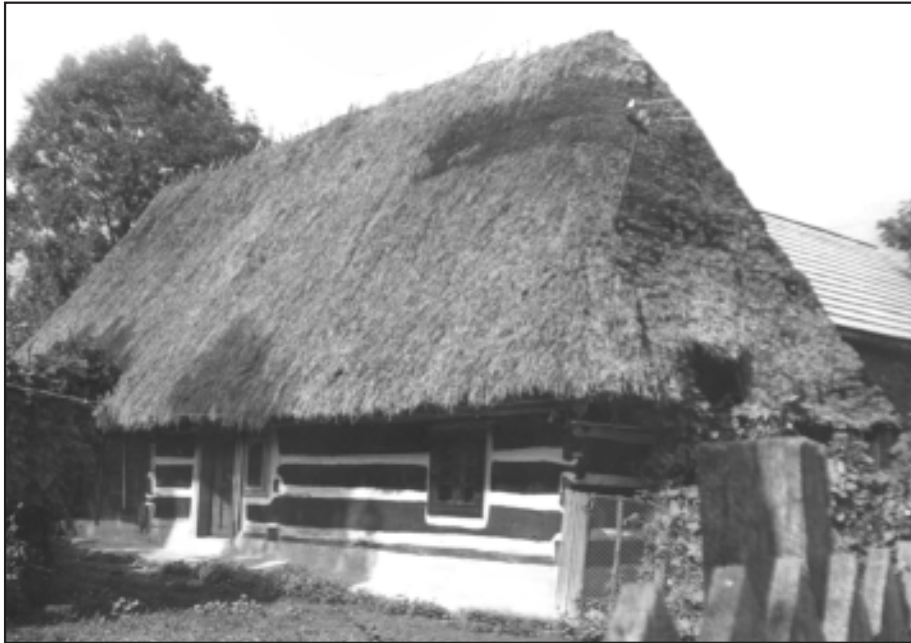
Хата кінця XIX ст. з характерною обмазкою і побілкою стиків брусів зрубу, вікон і дверей та чотирихилим солом'яним дахом у селі Тербля Тячівського району
