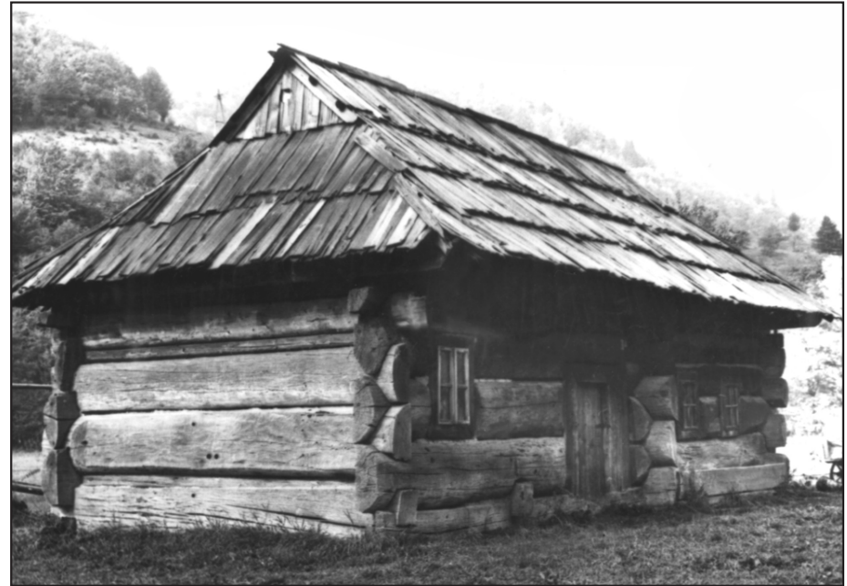
Гуцульська хата початку XVIII ст. з монументальним ясеновим зрубом та вкритим дранкою, з невеликими фронтонами з великих боків, дахом
