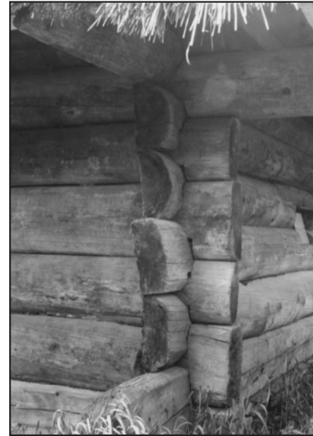
В'язання вуглів шляхом зарубок з обох боків кожної протесини у хаті кінця XVIII ст. в селі Оріховиця Ужгородського району. Фото автора
