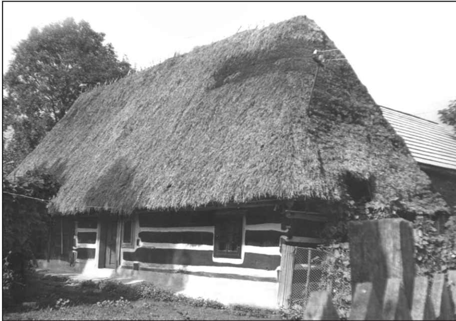
Хата кінця XIX ст. з характерною обмазкою і побілкою стиків брусів зрубу, вікон і дверей та чотирихилим солом'яним дахом у селі Теремля Тячівського району
