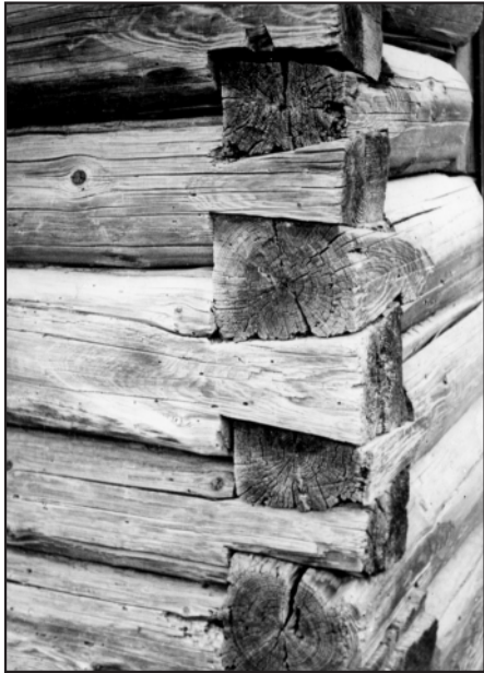
Кріплення зруба в "в лапу" ("німецький угол") у хаті 1878 р. в селі Верхній Бистрий Міжгірського району.
