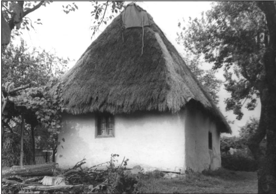
Хата кінця XIX ст. з обмазаним товстим шаром глини і побіленим зрубом та чотирисхилим, вкритим слоною, дахом у селі Широке Виноградівського району
