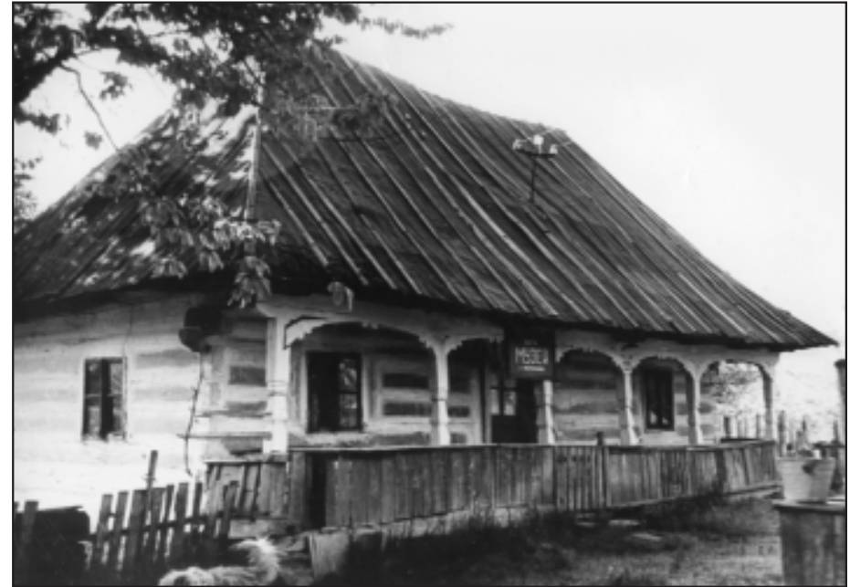
Напіввідкрита галерея з різьбленими опорними стовпцями в хаті кінця XIX ст. у селі Нересниця Тячівського району. Фото автора
