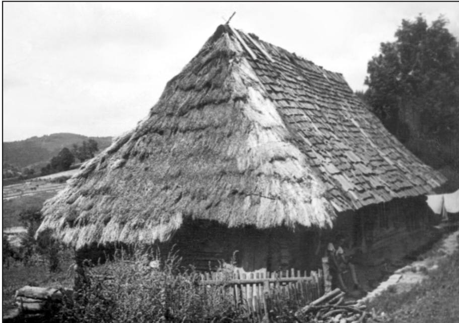
Хата кінця ХІХ ст. з комбінованою солом'яно-дранковою покрівлею у селі Чорноголова Великоберезнянського району
