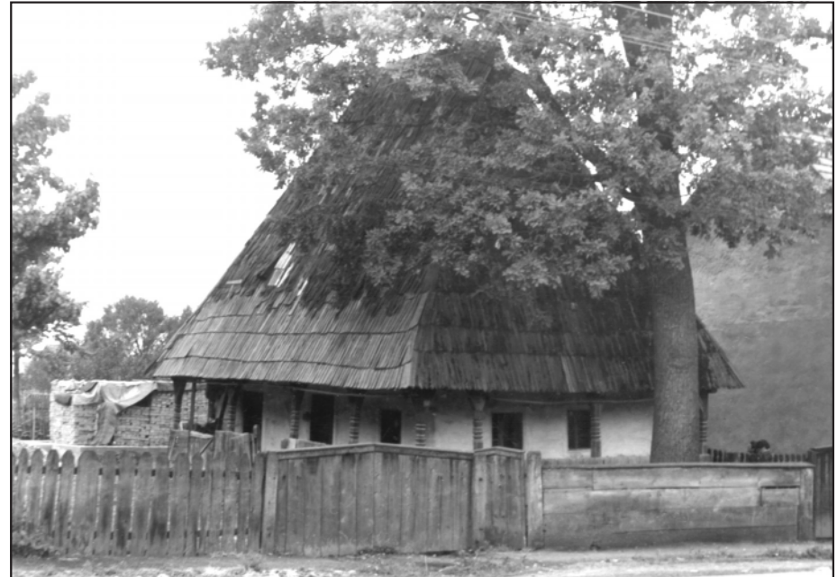
Хата початку XIX ст. з обмазаним і побіленим зрубом та високим чотирисхилим, покритим гонтом, дахом у селі Стеблівка Хустського району. Фото автора
