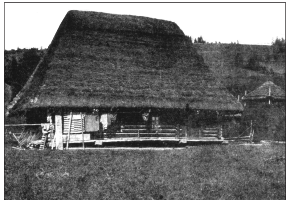
Бойківська хата з відкритим зрубом і високим чотирихилим, вкритим солом'яними сніпками, дахом у селі Подобовець Міжгірського району. Фото початку 20-х років XX ст.
