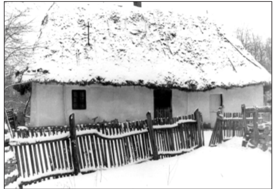
Двокамерне житло (хата+сіни; із сполученням сіней з хлівом через внутрішній двері) середини ХІХ ст. у селі Руські Комарівці Ужгородського району
