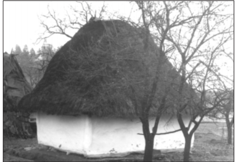
Тильна сторона хати середини XIX ст. з обмазаним і побіленим зрубом та характерним чотирихилим, вкритим товстим шаром сломи, дахом у селі Осій Іршавського району. Фото автора
