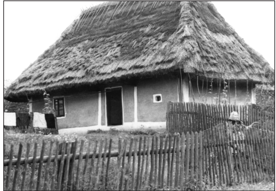
Хата кінця XIX ст. з обмазаним і пофарбованим насинь зрубом, характерним обрамленням у білий колір стиків зрубу, дверей і вікон, чотирихилим дахом під соломою ("жупами") та жердинами-ключинами для укріплення верху даху в селі Зарічево Перечинського району. Фото автора
