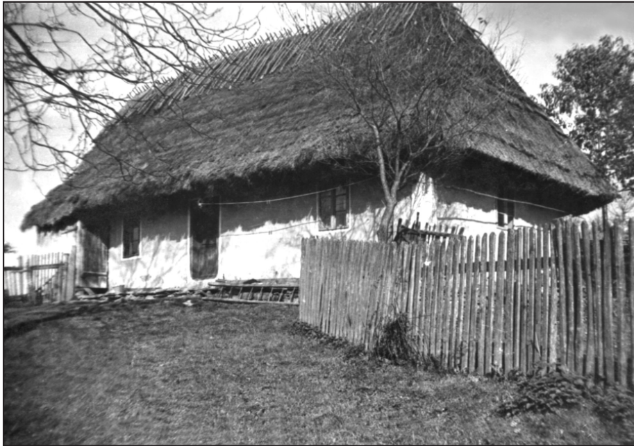
Хата кінця XIX ст. з побілим зрубом і характерною солом'яною сходоподібною покрівлею ("на ґарадичі") у селі Зарічево Перечинського району. Фото автора
