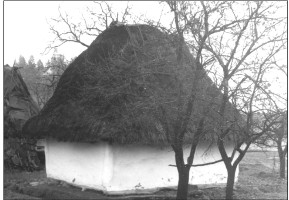
Тильна сторона хати середини XIX ст. з обмазаним і побіленим зрубом та характерним чотирисхилим, вкритим товстим шаром сломи, дахом у селі Осій Іршавського району. Фото автора
