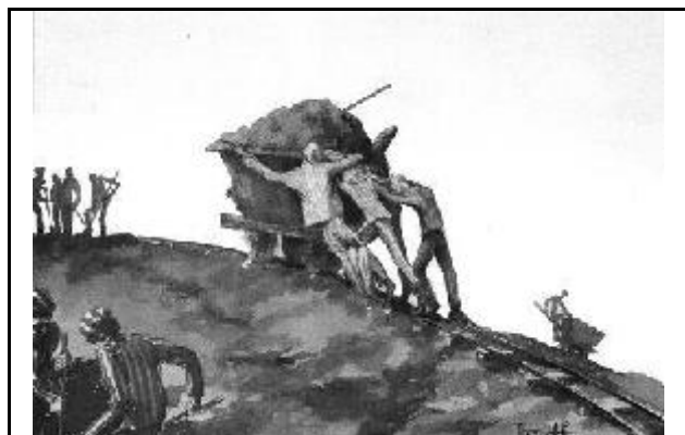
Будівництво зовнішньої залізничної гілки табору Дора на поверхні землі. Малюнок аквареллю колишнього в'язня – французького художника Моріса де Ля Пент'єра (Maurice de La Pintiere), зроблений у червні 1945 року
