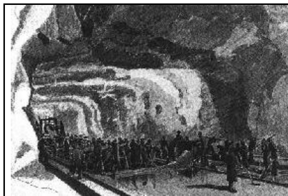
В'язні бетонують південну частину тунелю-А заводу Мітельбау-Дора під горою Конштейн. Малюнок кінця 1943 року цивільного німця - технічного службовця Вернера Брене (Werner Brahne)
