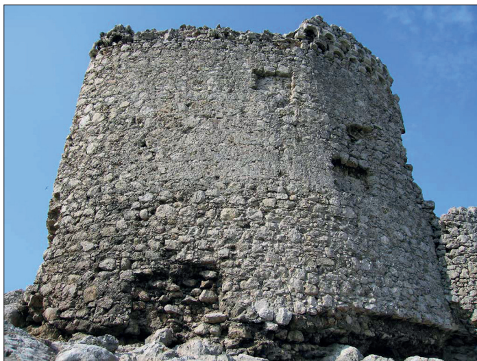
Мал. 9. Ніши для плит у мурі напівкруглої башти у східній частині цитаделі Чембало
