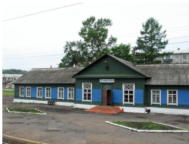
2011 рік. Селище Ізвесткове. Приміщення залізничної станції.
