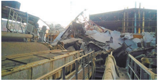
Обвал конструкцій покрівлі площею близько 3,5 тис. м 2 в одному з цехів підприємства «Кримський Титан» (виробник діоксиду титану) у серпні 2017 р.
