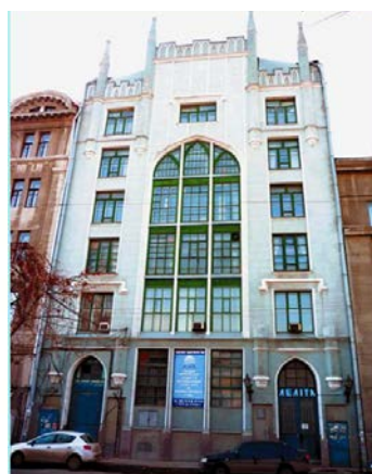
Будинок колишньої мануфактури "Зільберман та сини" на вул. Благовіщенській № 19 Арх. М.Є. Компанієць, 1910-ті рр. (Фото автора)
