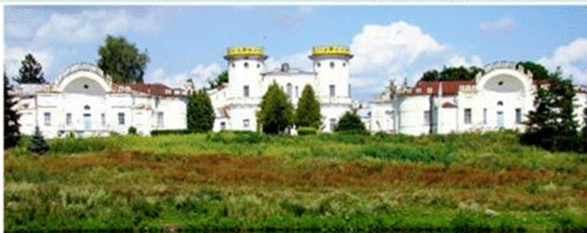
Садиба фельдмаршала П.А. Румянцева-Задунайського в с. Вишеньки на Україні. Арх. ймов. В.І. Баженов, М. Мосціпанов, 1780 р. ( http://obcn.ru/?p=1540 )
