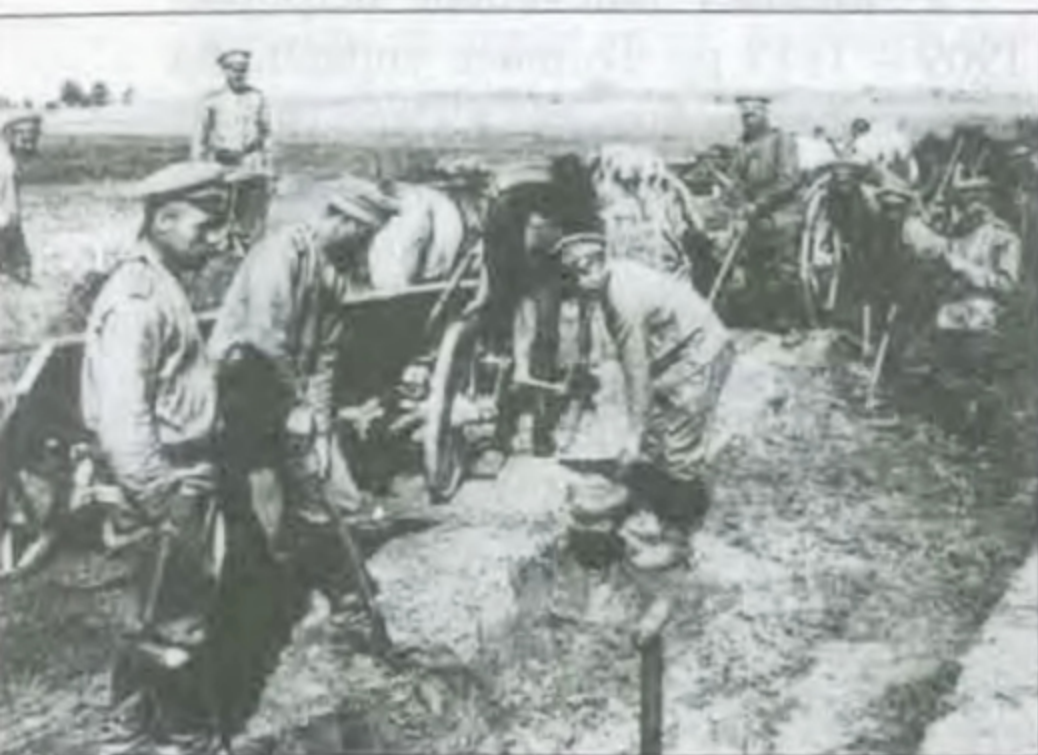
Земляні роботи на будівництві залізниці
