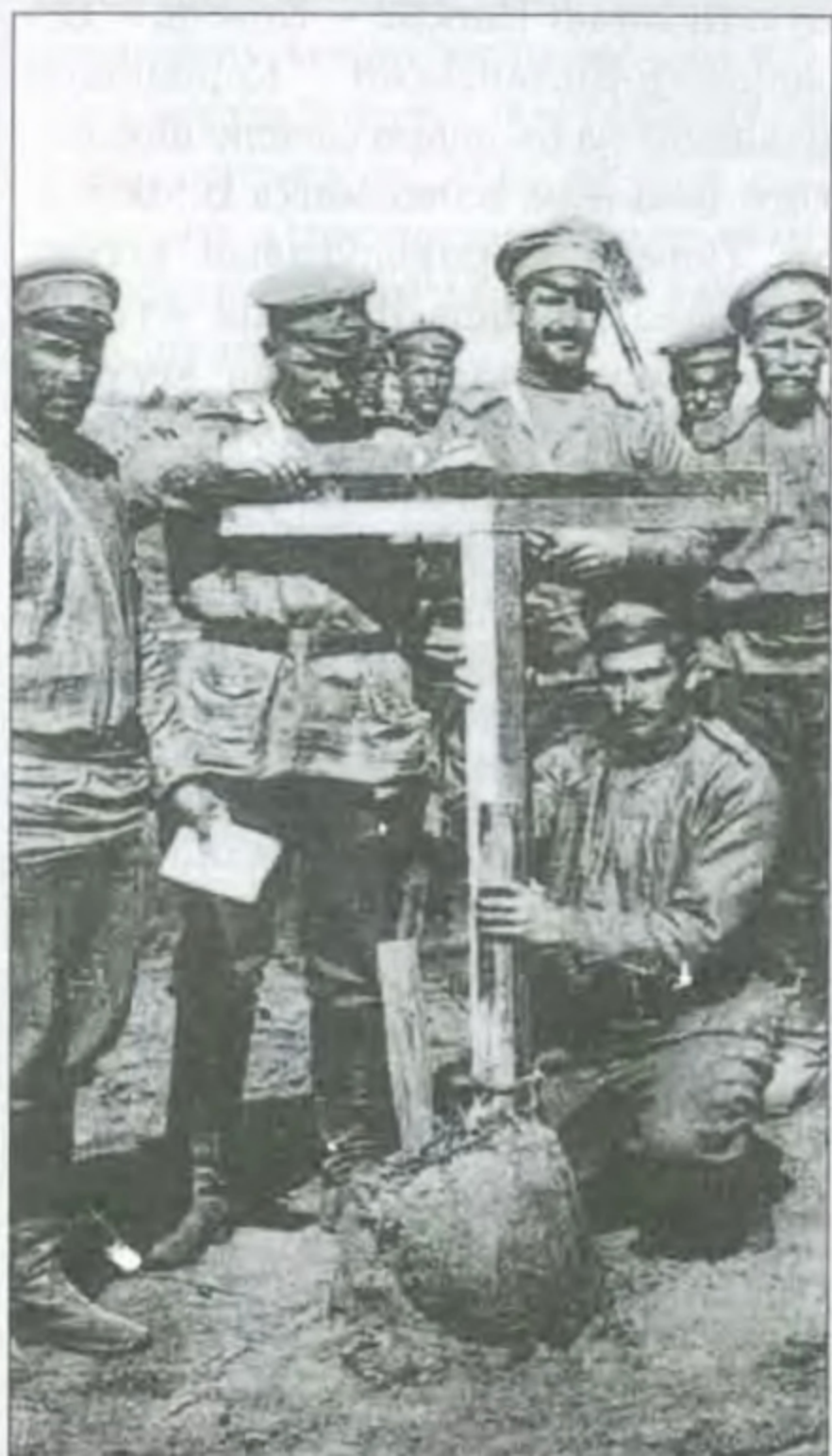
Встановлення візира для прокладання залізничної лінії
