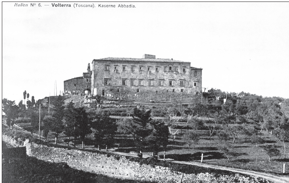
Volterra (Toscana), caserma Abbadia.
