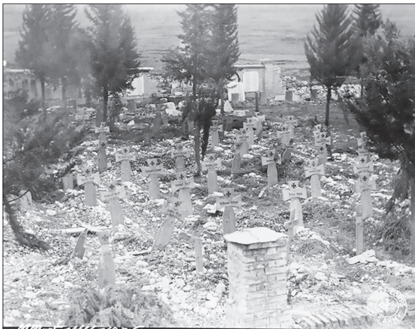
163rd Signal Photo Company, 10 febbraio 1944, Cassino area (il Cimitero civile di Cairra usato provvisoriamente come Cimitero Militare Tedesco).
