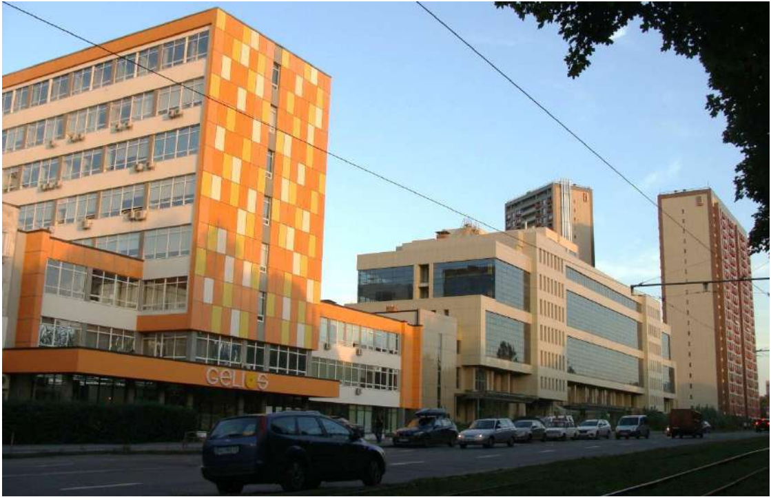
Бізнес-центри «Gelios» та «Сіґма», які знаходяться в реконструйованих корпусах Київського заводу реле і автоматики (промисловий район Відрадний), 2018 р.
