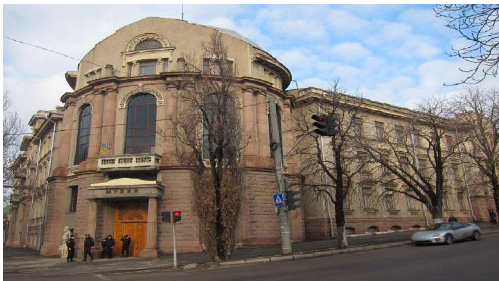
Мал. 49. вул. Троїцька, 29 Запоріжжя
