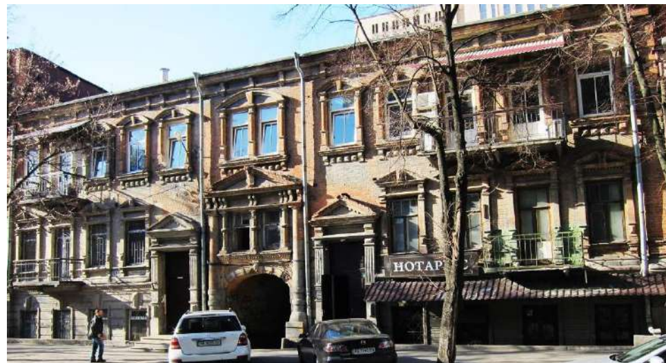
Мал. 2. вул. Барикадна, 11 а Дніпро
