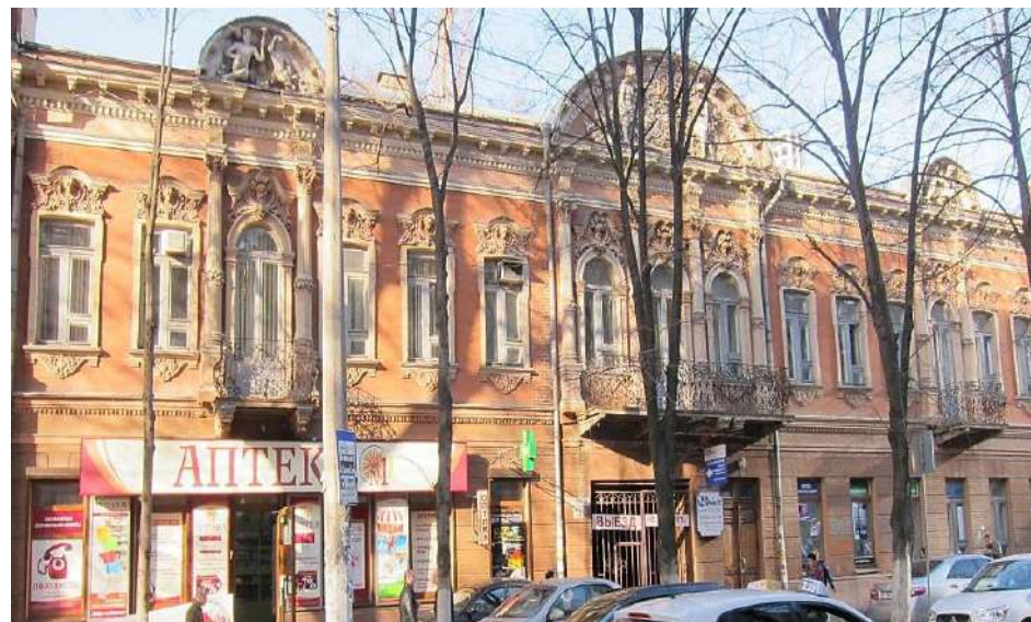
Мал. 46. вул. Глинки, 12 Дніпро
