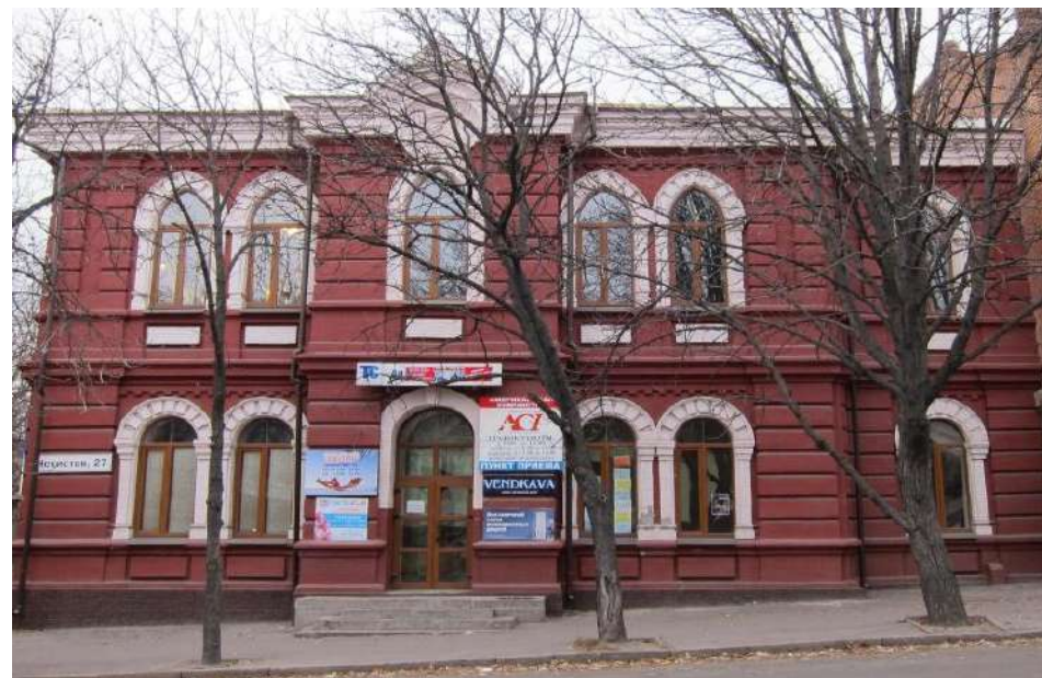
Мал. 58. вул. Троїцька, 27 Запоріжжя
