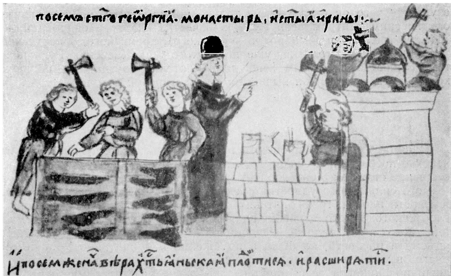
Рис. 35. Строительство в Киеве в начале XI в. (миниатюра Кенигсбергской летописи).
