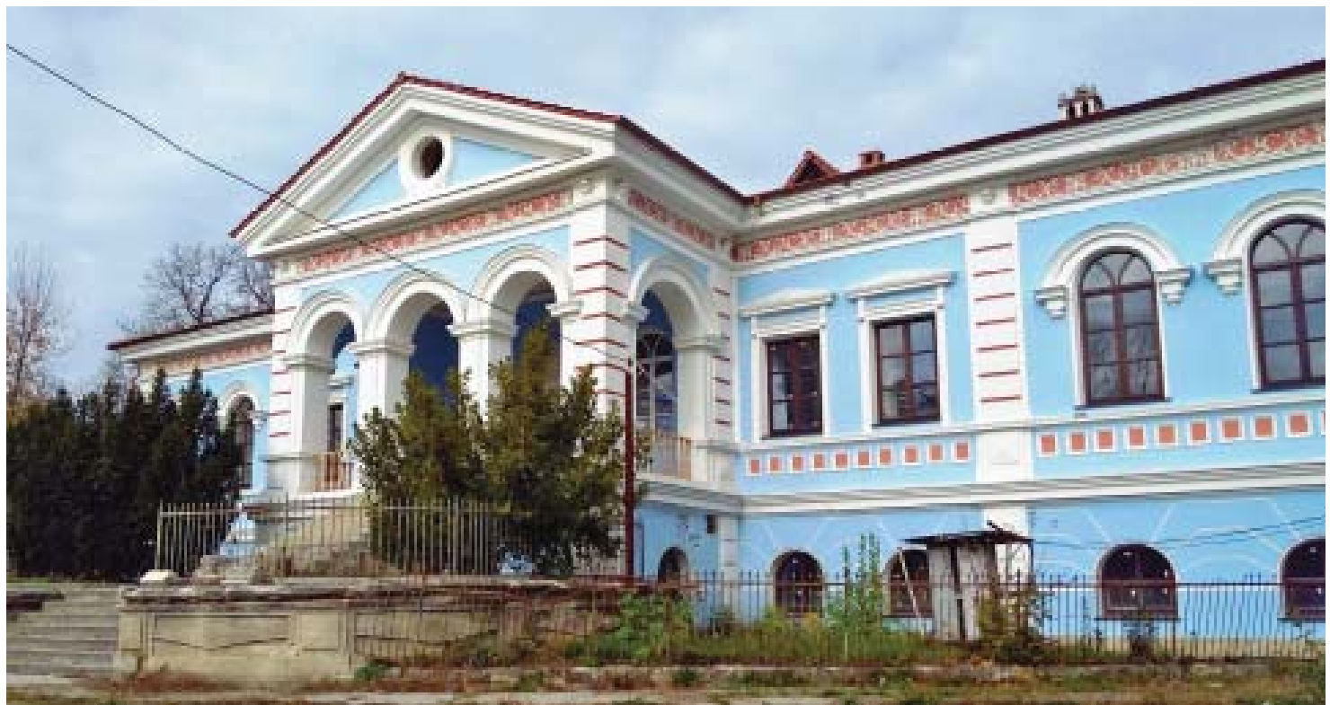
Загальний вигляд фасаду боярського будинку К. Баліюза, зведеного у псевдокласичному стилі (1852–1873 рр. побудови). с. Іванча Оргеївського р-ну Республіки Молдова
