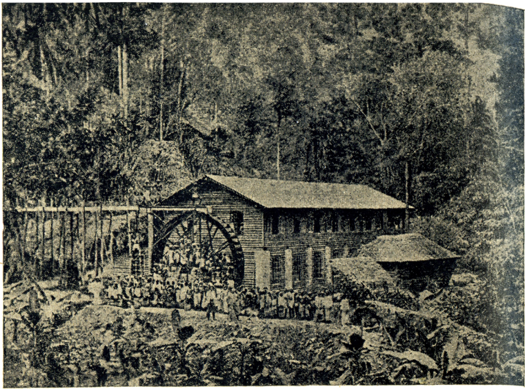
Водяне колесо чайної фабрики рухалось силою води.
