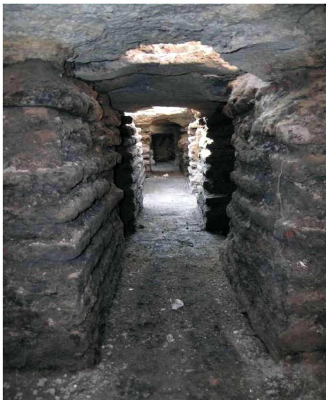
Рис. 74. Білгород-Дністровський, м. Аккерманська фортеця. Нижній двір. Лазня. Фрагмент гіпокаусту.
