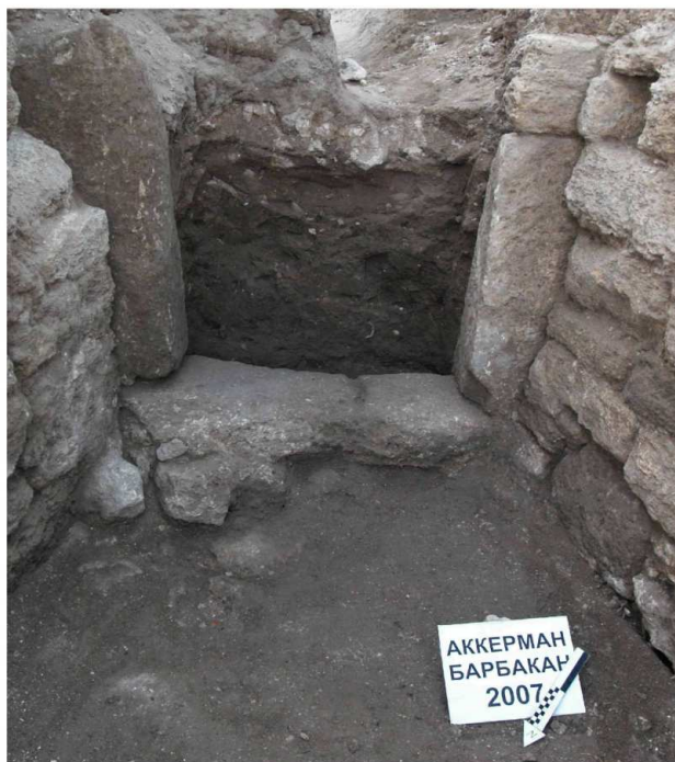
Рис. 70. Білгород-Дністровський, м. Аккерманська фортеця. Нижній двір. Вхід до барбакану з північного боку
