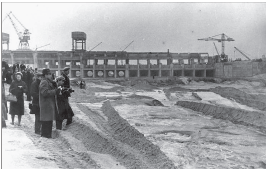
Будівництво Київської ГЕС.
