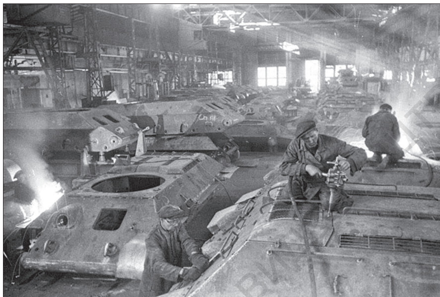
Склад льний цех Челябінського танкового заводу.
