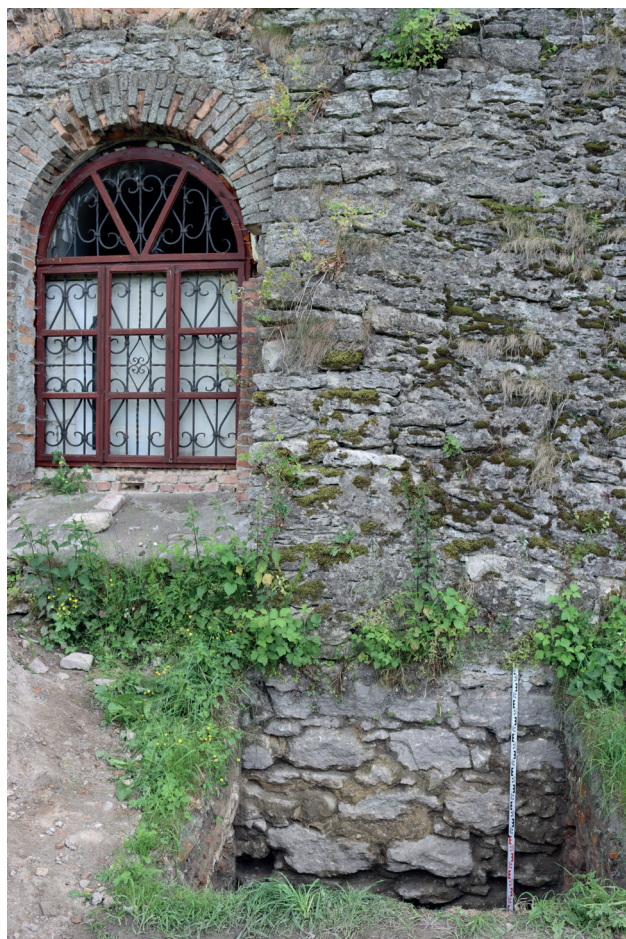
Рис. 4. Фундамент північної стіни палацу Любомирських. Верхній рівень шурфу.
