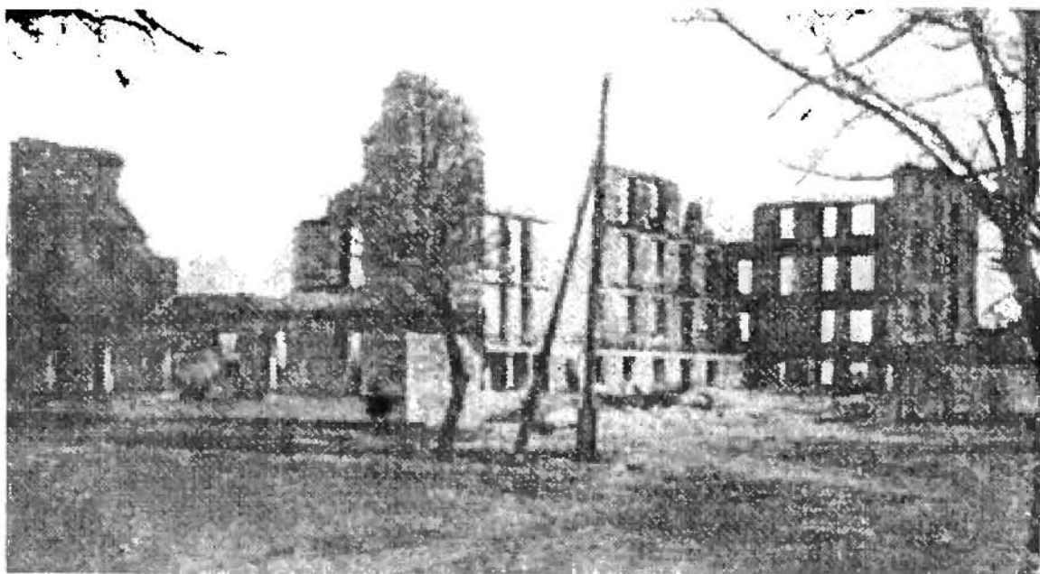
Зруйновані житлові будинки в м. Миколаєві
