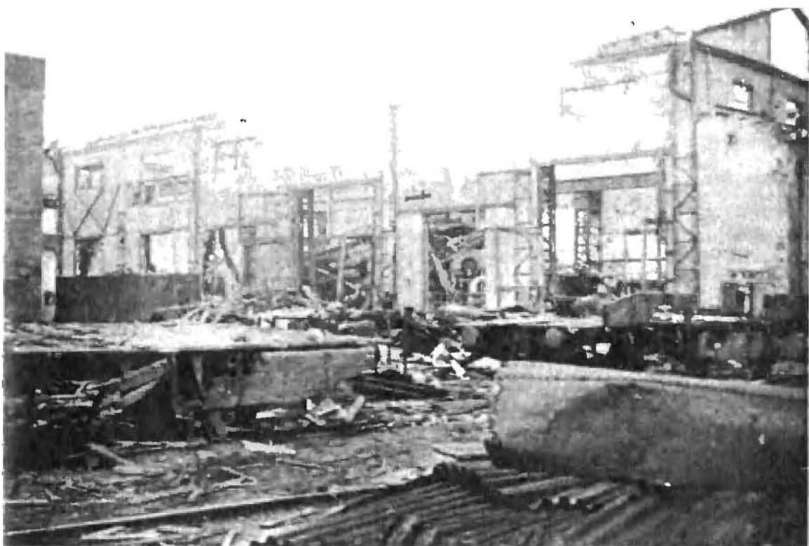
Зруйнований фашистами цех суднобудівного заводу ім. Носенка
