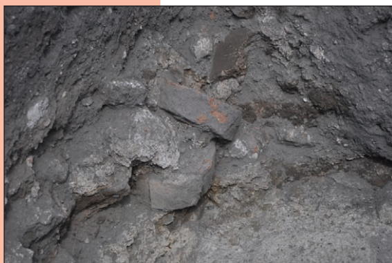
Бузовиця 1, будівельні рештки: блоки цегли, зв'язані вапняковим розчином і кругла плінфа, що лежить на вирівняній розчином долівці, III—IV ст.
