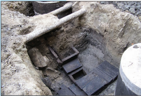
Дерев'яний каналізаційний колектор XVIII ст., вул. Руська (2006 р.)
