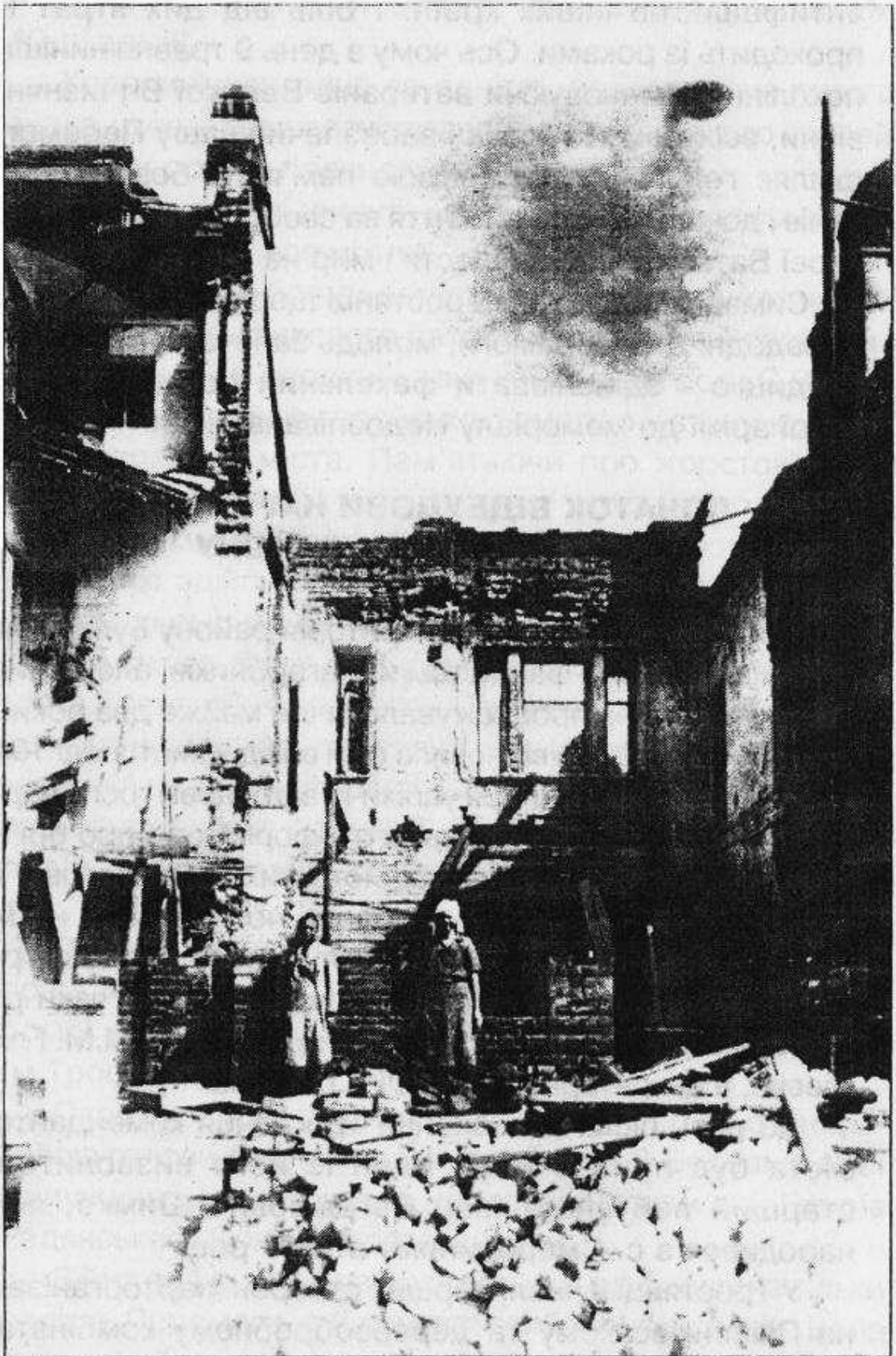
Приміщення лісодослідної станції, зруйноване під час фашистської окупації. Фото 1943р.
