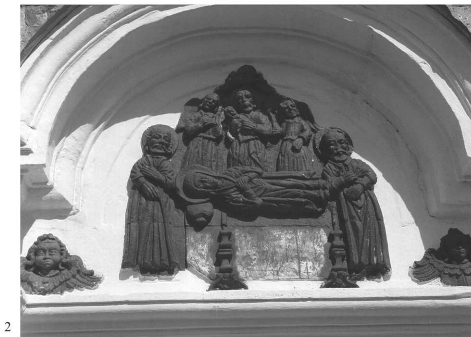
Рис. 171. 1 – западный фасад церкви Успения Пресвятой Богородицы в с. Крылос. XVI в.; 2 – тимпан портала, фрагмент (фото автора 2005 г.)
