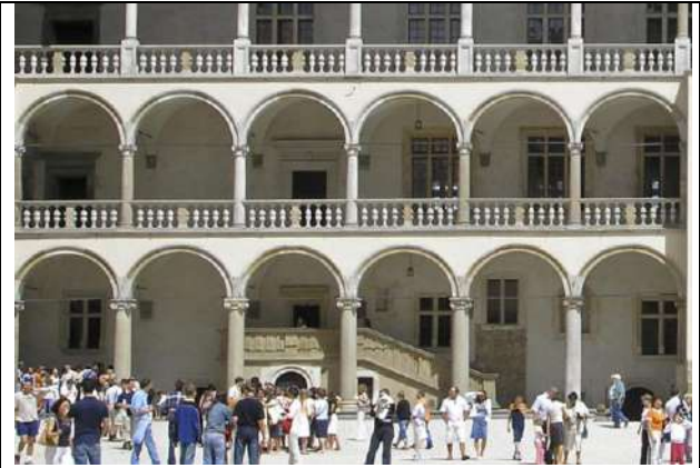
Рис. 15. Склепінчасті галереї Вавеля, які спираються на ряд консольних елементів фасаду. Фото Gryffindor з Wikimedia Commons.
